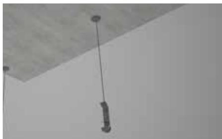
Posare i pendini. In caso di solaio in latero-cemento fissare i pendini sui travetti.
