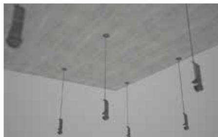
Il passo dei profili va definito in funzione dei carichi e del solaio.
