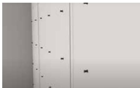
Fissare la seconda lastra di cartongesso al centro e ai lati con le apposite viti "a doppio filetto", sfalsando le lastre oppure con la colla.
