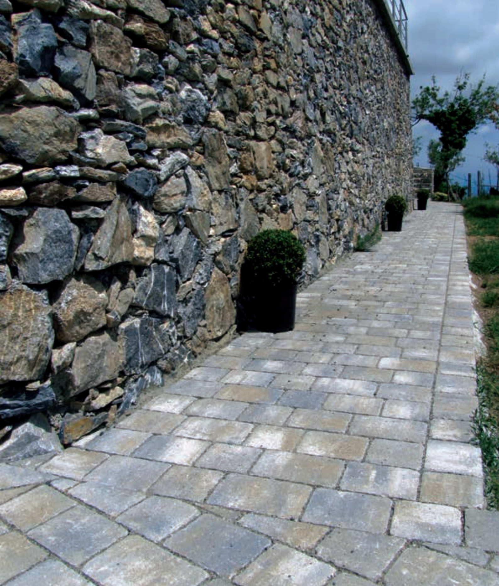
TREPEZZI VIEILLI couleur LUSERNE - scellement du joint avec sable polymère
