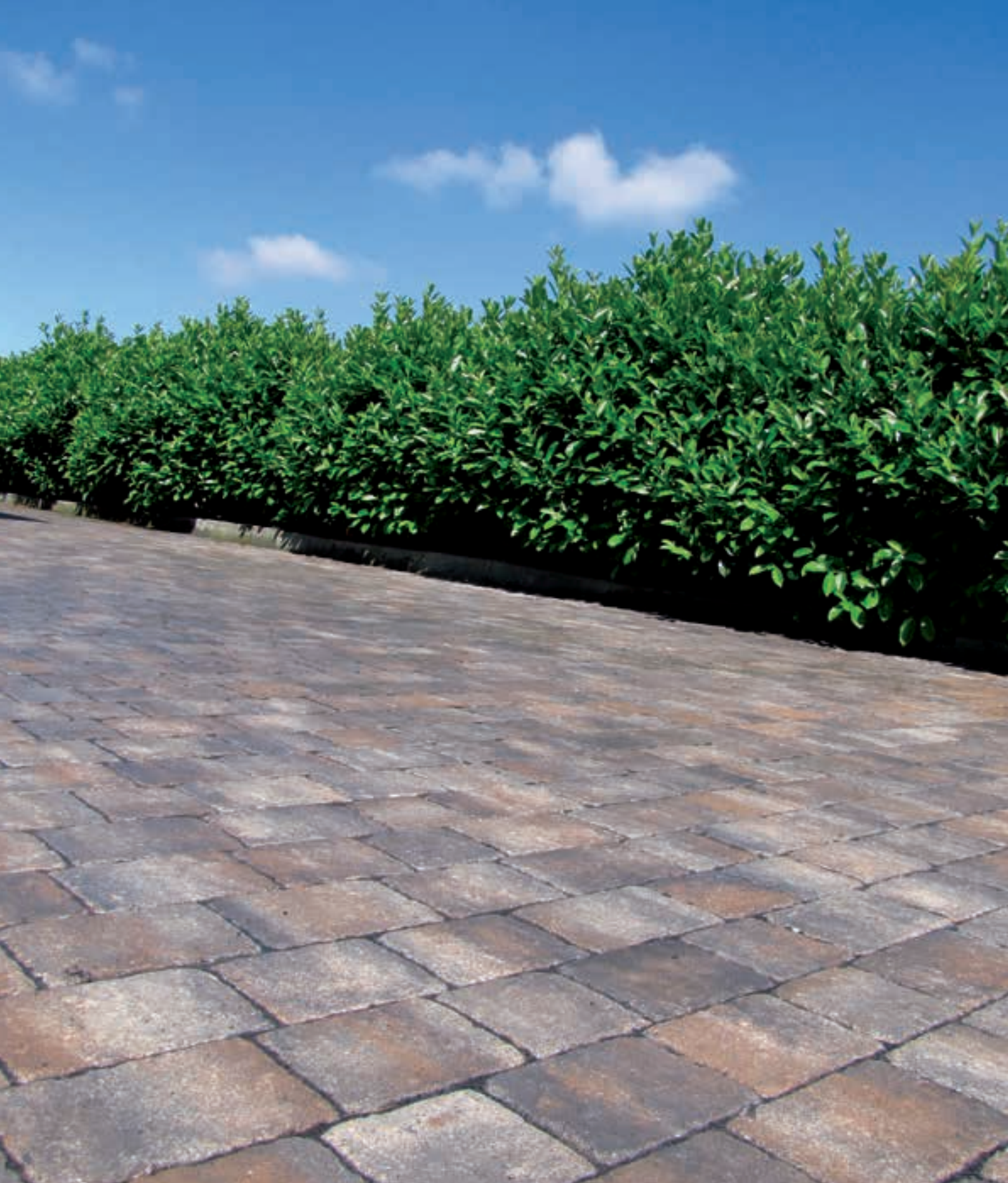
VIA SALARIA VIEILLI couleur MIX ORANGE - scellement du joint avec sable polymère
