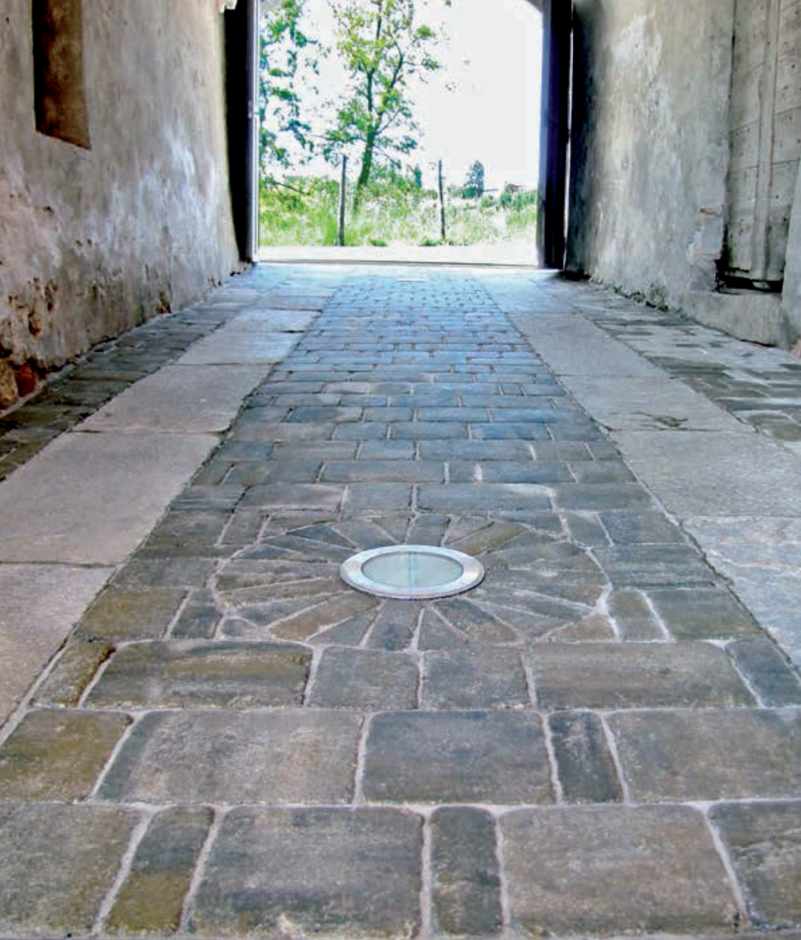
VIA MAESTRA couleur LUSERNE – scellement du joint avec sable polymère
