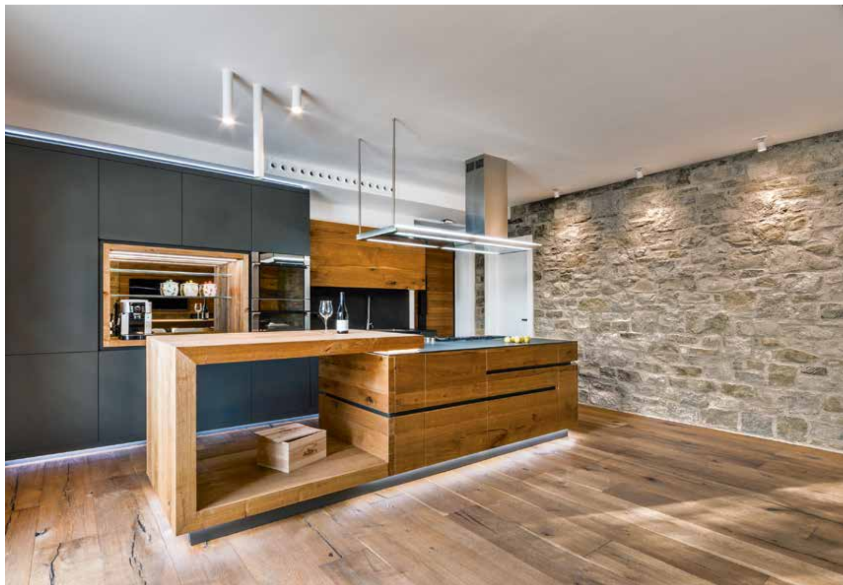
murogeopietra® mod. Alberese / P88 Tonalità unica Posa con fuga finitura Piena con malta GEOBI a grana grossa colore Marche Profilo SQUADRATO
