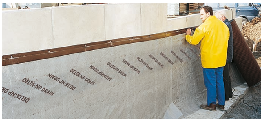
DELTA®-NP DRAIN drena le infiltrazioni d'acqua ed esclude la formazione di ponti d'umidità.
