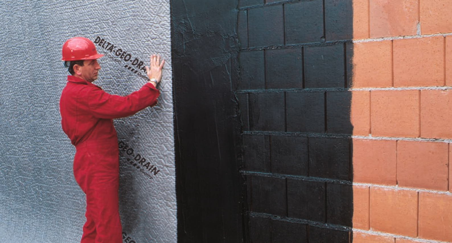
Il sistema di protezione e di drenaggio DELTA®-GEO DRAIN Quattro è posato con il piano di scorrimento (giallo) rivolto verso la muratura ed il non tessuto verso il terreno.
