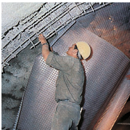
Tunnel di Brachbach (Germania).
