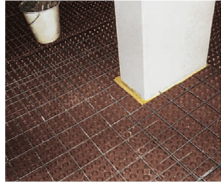
DELTA®-MS 20 messo in opera fra la soletta e il pavimento blocca l'acqua ascendente in caso di risalita della falda e la convoglia verso un tubo di drenaggio.
