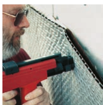
Installazione immediata: fissaggio delle membrane alveolari con l'aiuto di una pistola sparachiodi.
