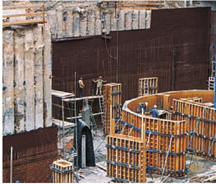
Parcheggio sotterraneo di un albergo a Francoforte (Germania). L'acqua che fuoriesce dal terreno roccioso viene evacuata grazie a DELTA®-MS.
