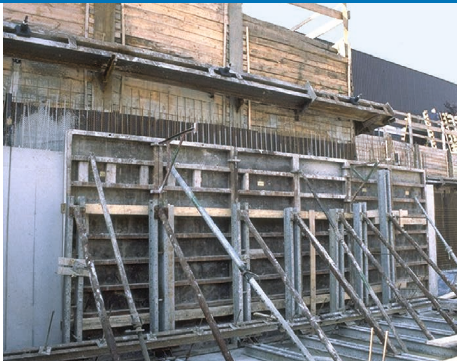
La membrana DELTA® viene posata direttamente contro le tavole di legno con il geotessile a contatto con le assi.
