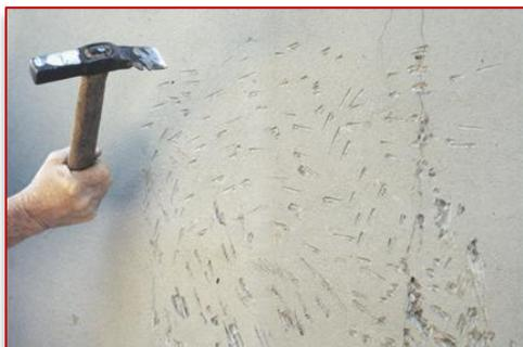
In ristrutturazione, si procede alla rimozione dell'intonaco deteriorato e alla martellatura di quello resistente. Su nuove costruzioni sarà sufficiente realizzare un intonaco grezzo. Per superfici in c.a. rimuovere la presenza di eventuali disarmanti mediante lavaggio.
