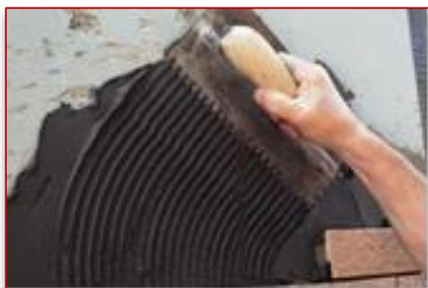
Si procede alla stesura del collante mediante una spatola dentata (denti da 0.5mm).
