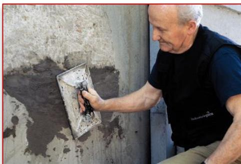
Le eventuali porzioni di intonaco deteriorato che sono state in precedenza rimosse, andranno ripristinate mediante rasatura grezza eseguita con una normale malta bastarda.
