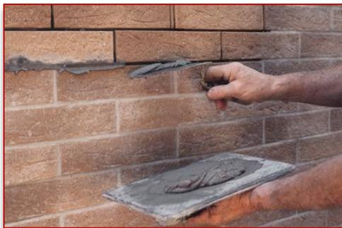
Tale operazione va eseguita utilizzando la tecnica del rigiuntaggio, ovvero applicando in un momento successivo all'incollaggio il sigillante all'interno di ogni singola fuga. L'utilizzo di una pistola per fughe semplifica notevolmente l'applicazione, consentendo inoltre di sporcare meno la muratura. Come sigillante può essere utilizzata una normale malta bastarda o in alternativa sigillanti preconfezionati.
