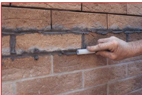
La si esegue passando con un tondino in gomma su ogni singola fuga. È buona regola realizzare profili che non consentano ritenzione d'acqua, consigliamo giunti "a filo" o leggermente concavi verso l'interno. L'operazione di stilatura va eseguita interrompendo l'operazione di sigillatura ogni 5 o 6 corsi.
