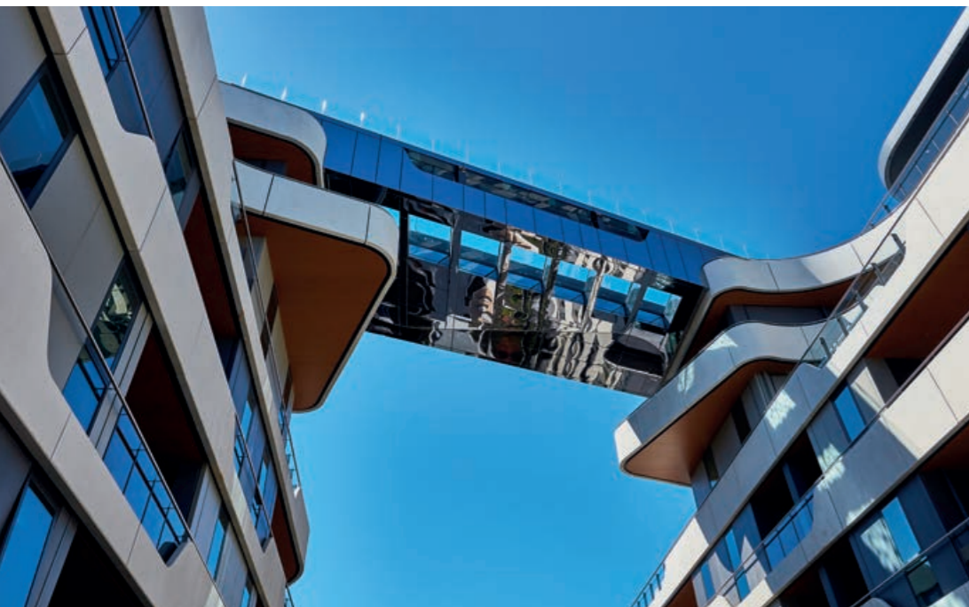
Melbourne, Australia Hawthorn Park Apartments, Sky pool sospesa con fondo trasparente che collega due edifici
