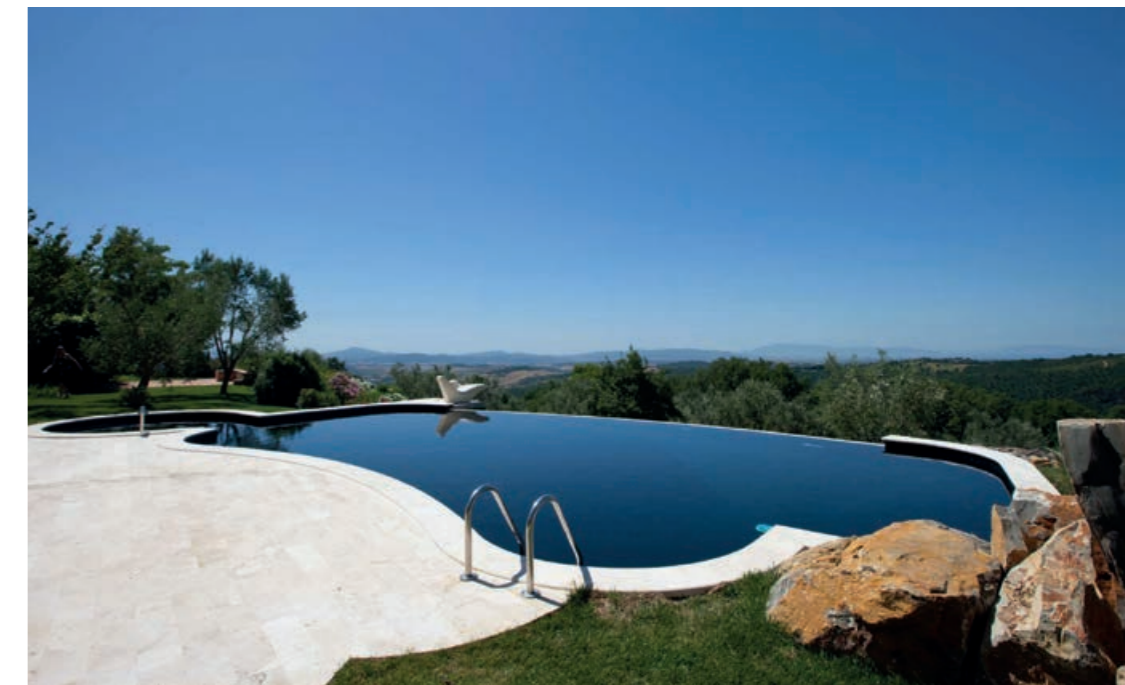
Scansano (Gr) Residenza privata, piscina a forma libera con rivestimento nero
