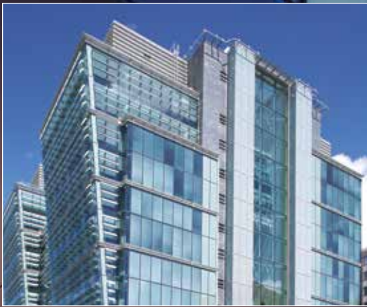
“Snow Hill” - Birmingham, Inghilterra Progetto dello Studio Sidell Gibson Architects
