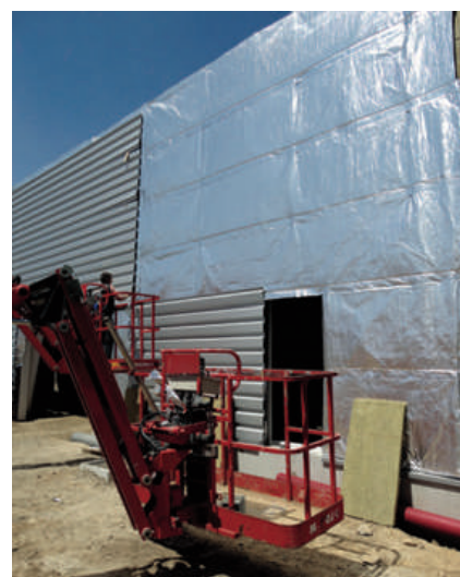
Isolamento di pareti ventilate
