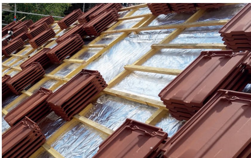
Isolamento di coperture
