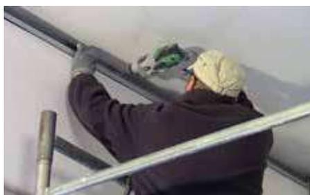
Fissare le guide lungo il perimetro superiore della stanza
