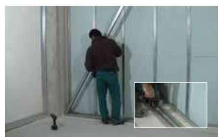
OPZIONE: realizzare la 2° struttura metallica per creare una parete doppia e fissare la 2° lastra di cartongesso sfalsandola dalla 1°
