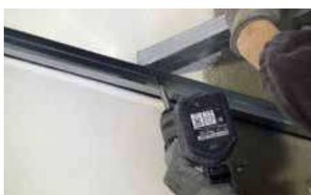
Fissare alle guide lungo il perimetro l'orditura metallica portante
