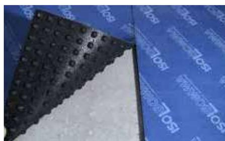
Accostare i pannelli senza lasciare spazi vuoti e ricoprire l'intera superficie da isolare
