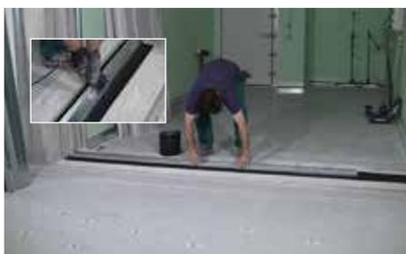
Fissare le guide metalliche al solaio, alle pareti laterali e al soffitto
