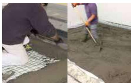
Gettare il massetto in sabbia e cemento o autolivellante, rinforzato con rete d'armatura
