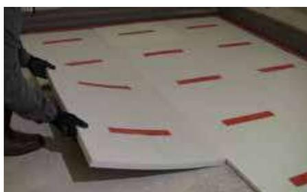
Posare Highmat in successione alternata lungo ogni fila
