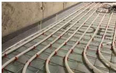
Nel caso di riscaldamento a pavimento posare la rete e il tubo del riscaldamento a pavimento
