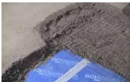
Realizzare il massetto, se necessario l'armatura del massetto in fase di getto
