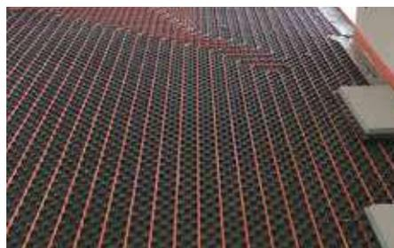
Nel caso di riscaldamento a pavimento posare il pannello radiante sopra al materassino
