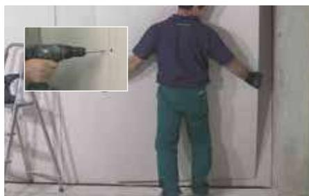
A distanza di 2/3 ore fissare l'eventuale seconda lastra di cartongesso al centro e ai lati con le apposite viti "a doppio filetto", sfalsando le lastre
