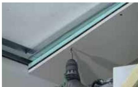
Fissare il pannello con viti da 55 mm ogni 15 cm
