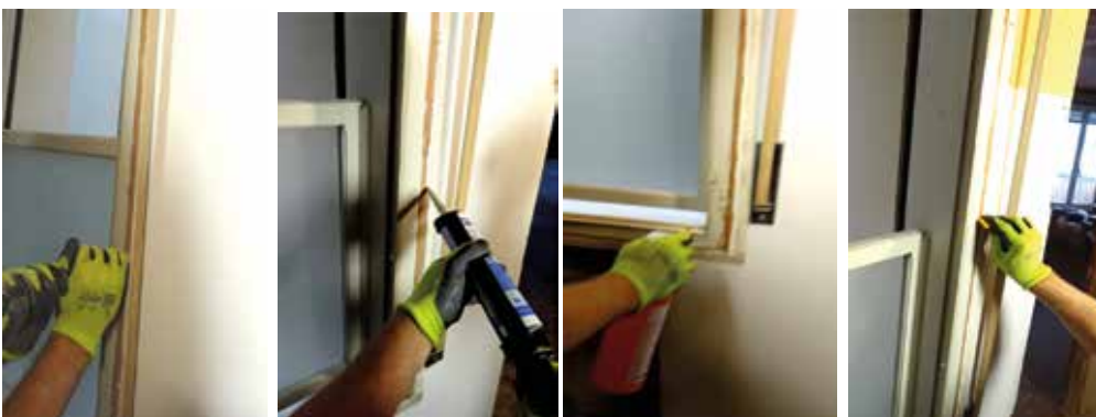
Sequenza della sigillatura del telaio murato con PosaClima MS Polimero
