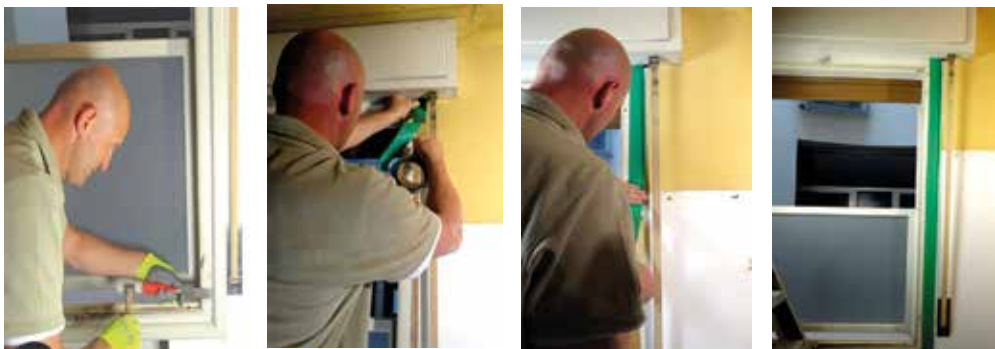
Sequenza della sigillatura del telaio murato con Barriera vapore Renova
