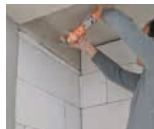
Sigillatura giunti sottili/verticali/orizzont.
