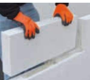
Posa di blocchi GASEBETON®
