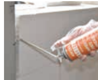
Sigillatura giunti sottili/verticali/orizzont.
